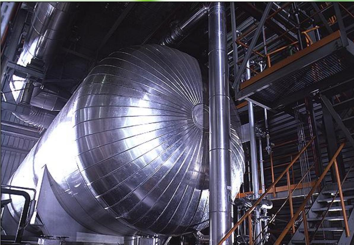
Конденсатор (лат. *condenso* — уплотняю, сгущаю) — теплообменный аппарат для конденсации (превращения в жидкость) паров вещества путём охлаждения.
