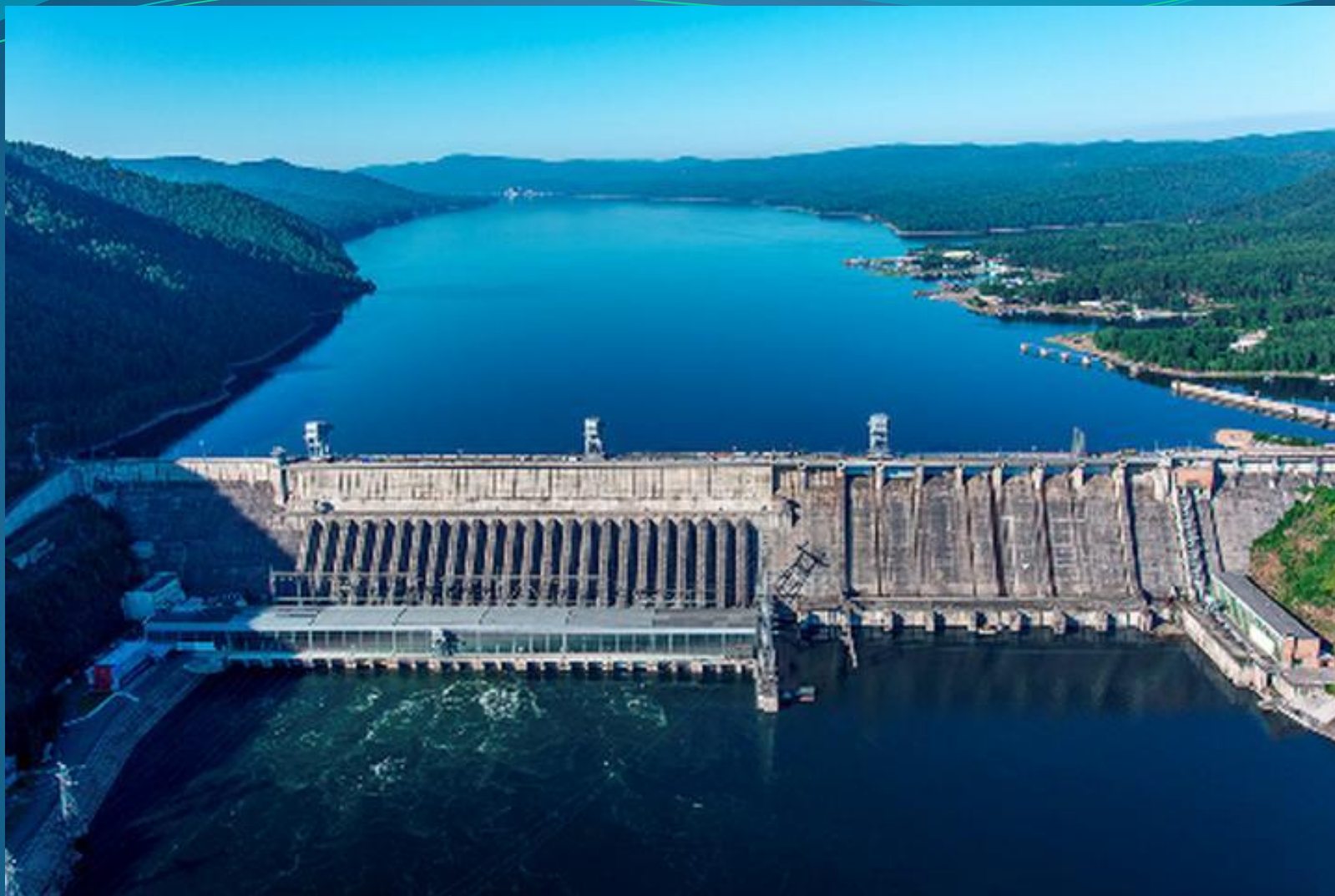
Красноярская ГЭС N=6 ГВт
