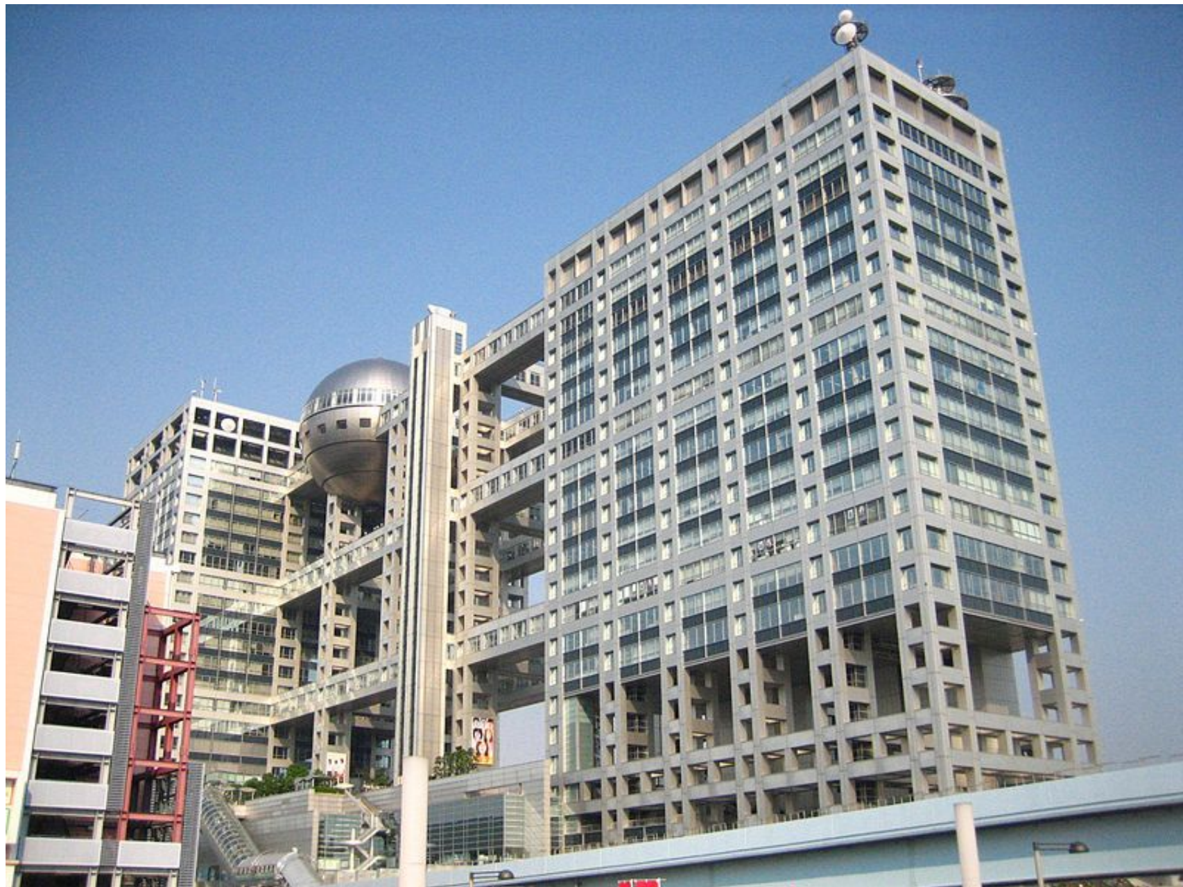
Штаб-квартира Fuji TV. Архитектор Кэндзо Тангэ.
