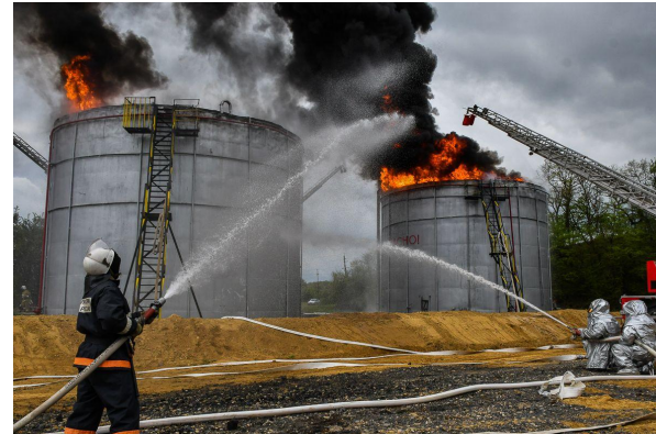
на объектах добычи, хранения и переработки легковоспламеняющихся, горючих и взрывчатых веществ
