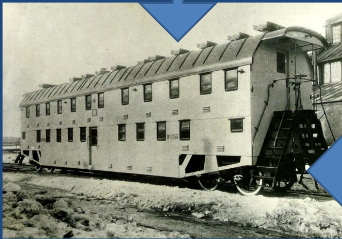
Двухэтажный вагон, построенный на Тверском заводе в 1905 году
