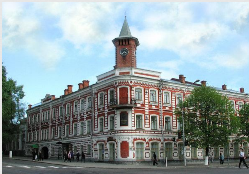
Дом Гончарова. Современный вид
