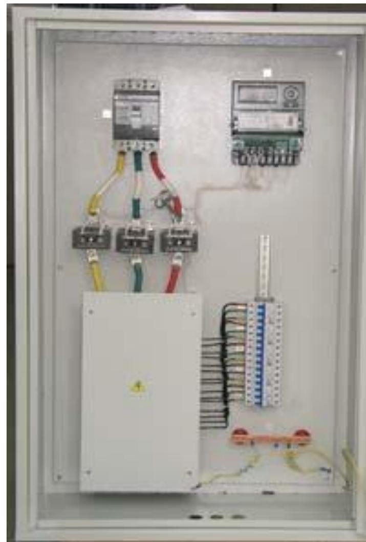
Предназначены для преобразования напряжения 220В (380В) переменного тока с частотой 50Гц в безопасное напряжение 12 В (24 В, 36 В, 42 В) и служат для питания линий ремонтного освещения подключения переносных светильников и электроинструмента.
