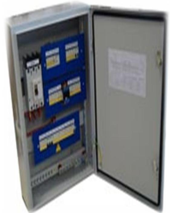
Предназначены для распределения электроэнергии и защиты электрических установок при перегрузках, для нечастых оперативных включений и отключений электрических цепей, защиты от перегрузок и токов короткого замыкания осветительных сетей трехфазного переменного тока напряжением 380/220В частотой 50Гц.
