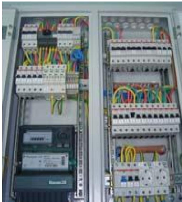
Предназначены для приема, распределения и учета электроэнергии напряжением 220В (380В).
