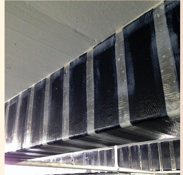
Усиление строительных конструкций углеволокном
