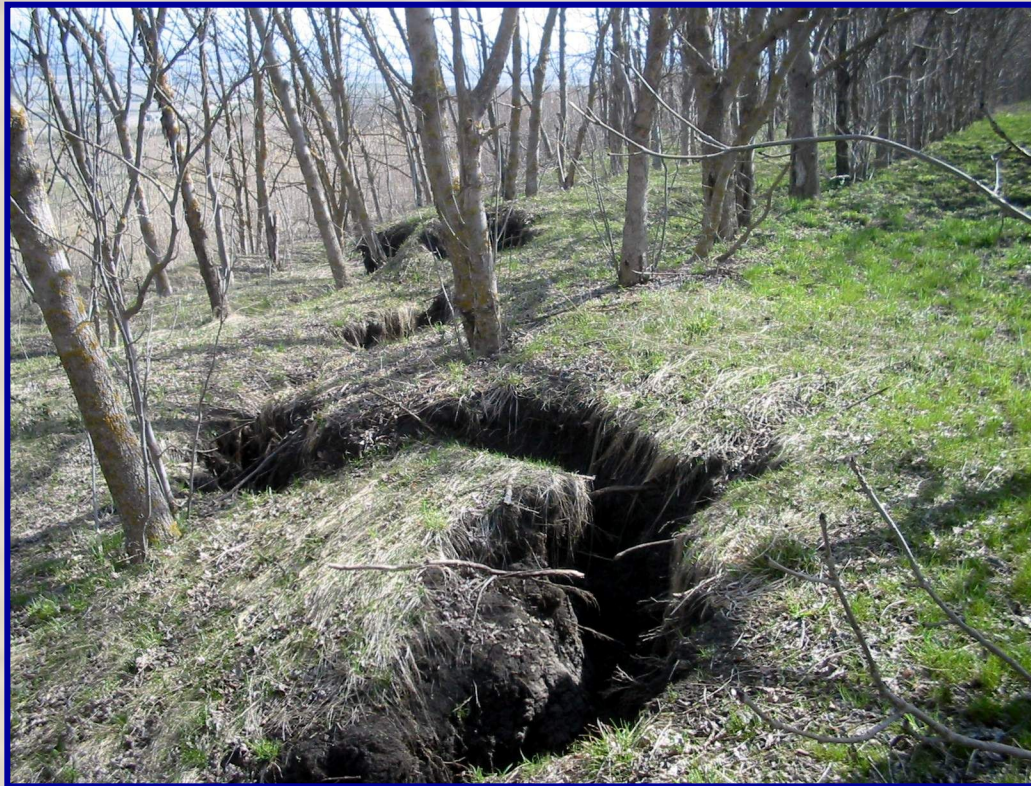
Оползневые трещины закола в лесопосадке (май 2007г.).
