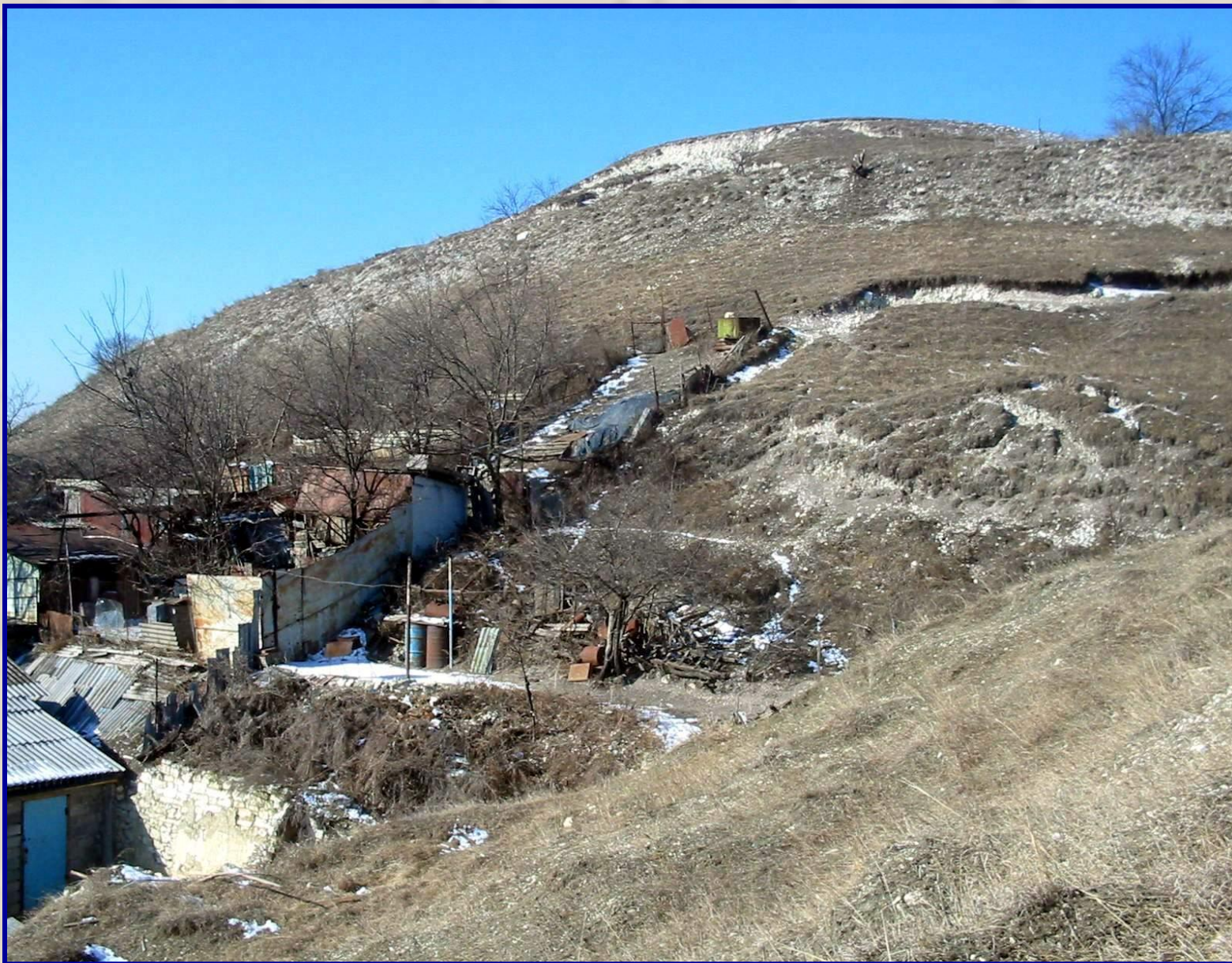
Оползни над домами в пер. Карьерный (март 2007г.)
