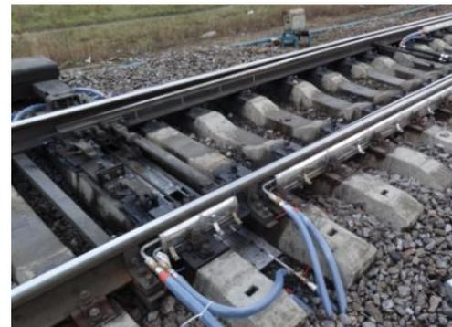
Система геотермического обогрева стрелочного перевода
