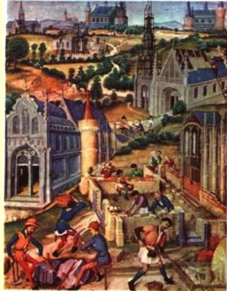
Строительство городских зданий
