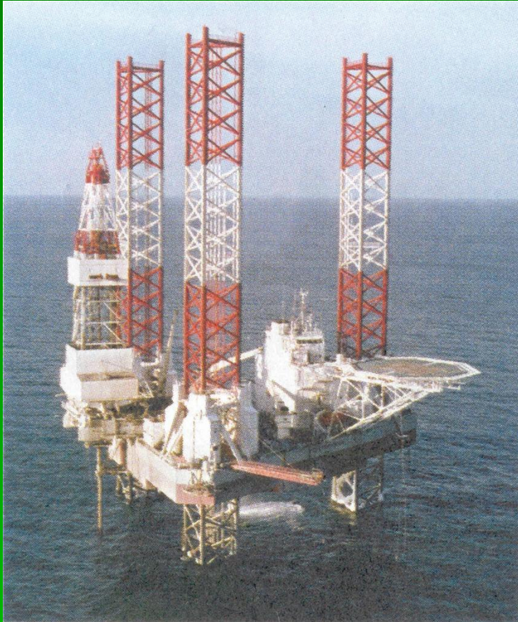
Плавучая бурильная установка на шельфе Охотского моря
