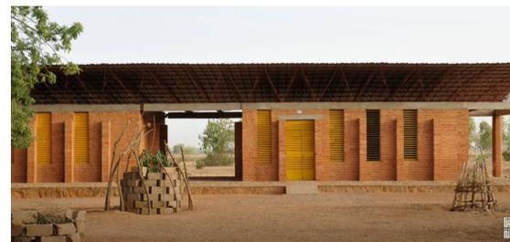
И одной из самых важных особенностей, которые он использовал, было использование глины, потому что использование бетона относительно дорого и требует использования электричества, которого нет в деревне... Кроме того, глина является экологически устойчивым органическим материалом, который легко доступен. Глиняные стены обладают высокой инерционностью, что заставляет их выполнять роль климатического барьера, в результате чего происходит задержка притока тепла.
