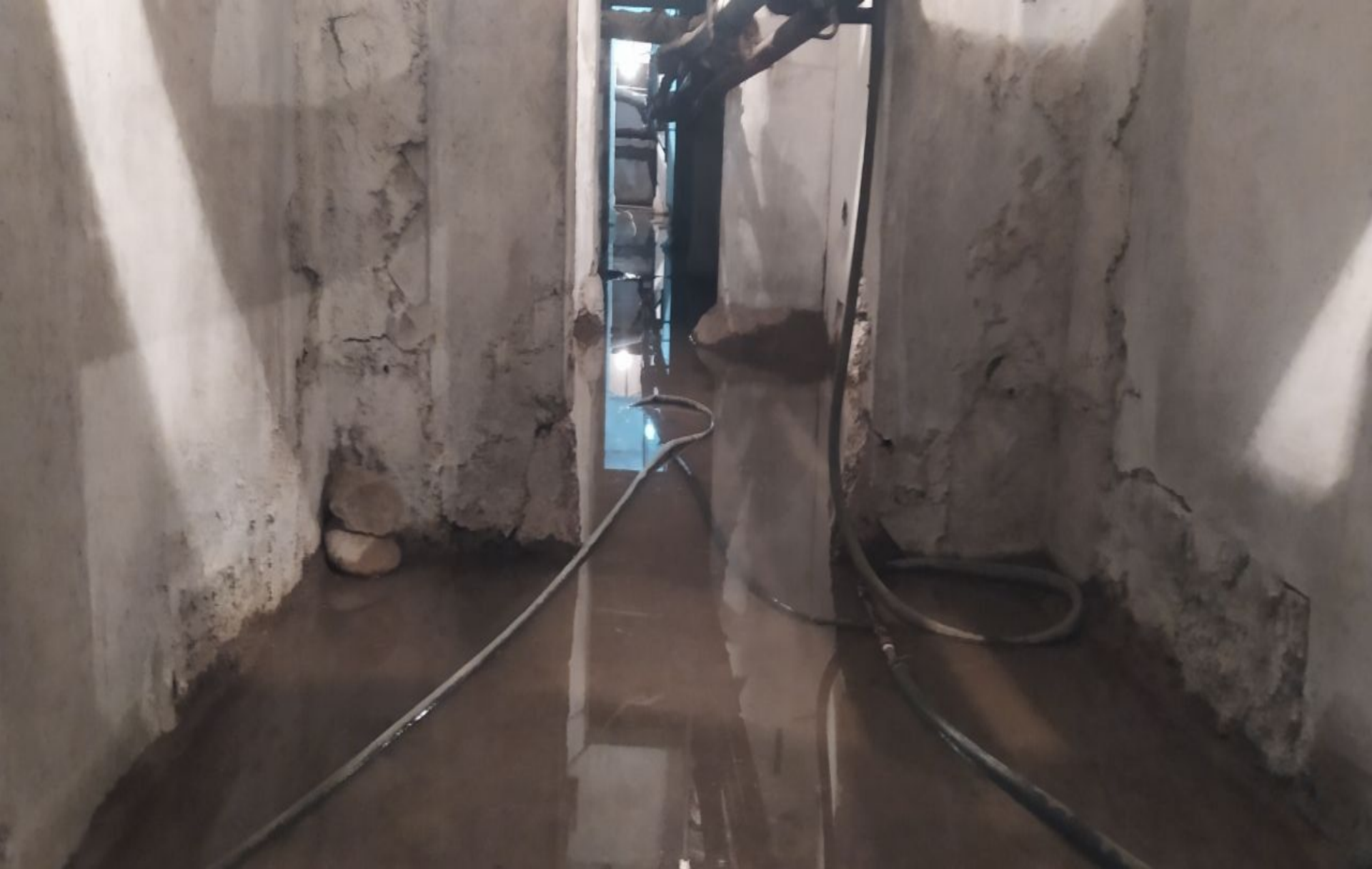
Яшинобод тумани Истиқлол маҳалласи Паркент “Призавой” мавзе 4/5-уй ер тўласи канализация турбалари таъмир талаб сув оқади (2-сектор). (Бориб ўрганилган вақти 17.10.2022 йил соат (9:35))
