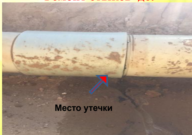
Ремонт стыков до.
