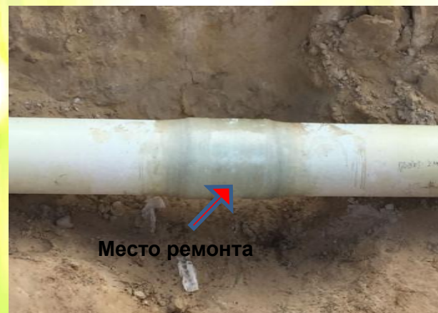
Ремонт стыков после.
