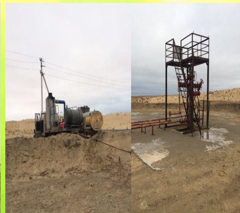
Горячая промывка выкидных линии скважины.
