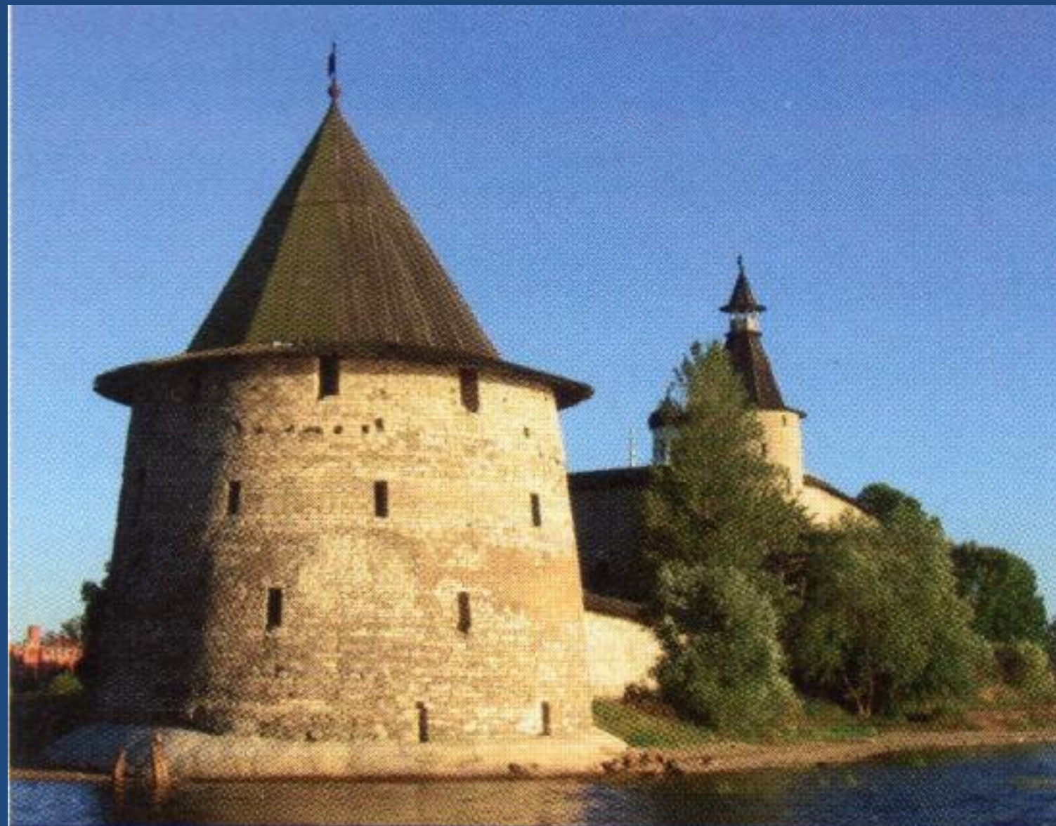
Башня Плоская псковского Крома, активно укреплявшегося во времена Ивана III.
