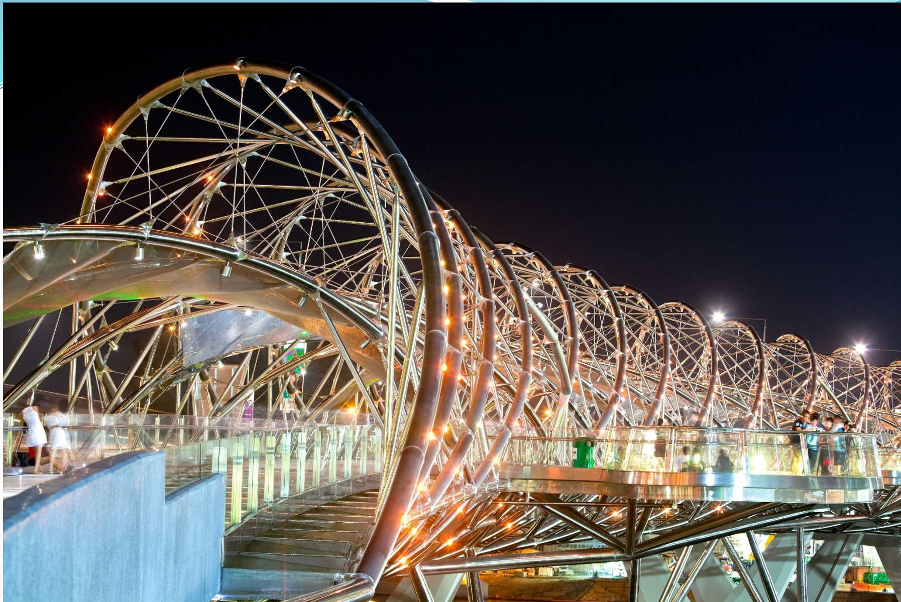
Мост в Сингапуре
