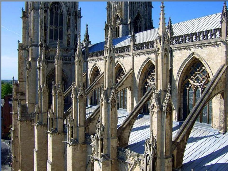
Специальная соединительная арка, которая перебрасывалась от центрального нефа базилики к контрфорсу, передавая ему нагрузку свода.
