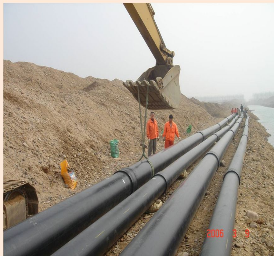
河南金山化工集团输卤管线
