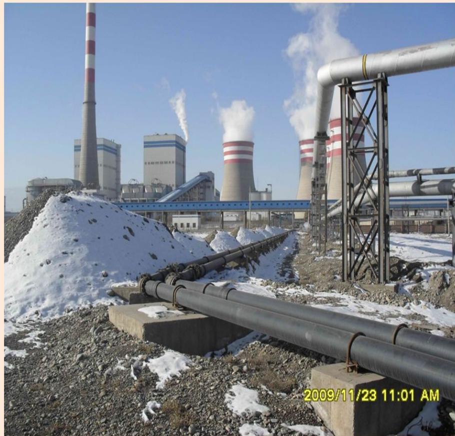
酒钢集团宏晟电热公司二期除灰管线
