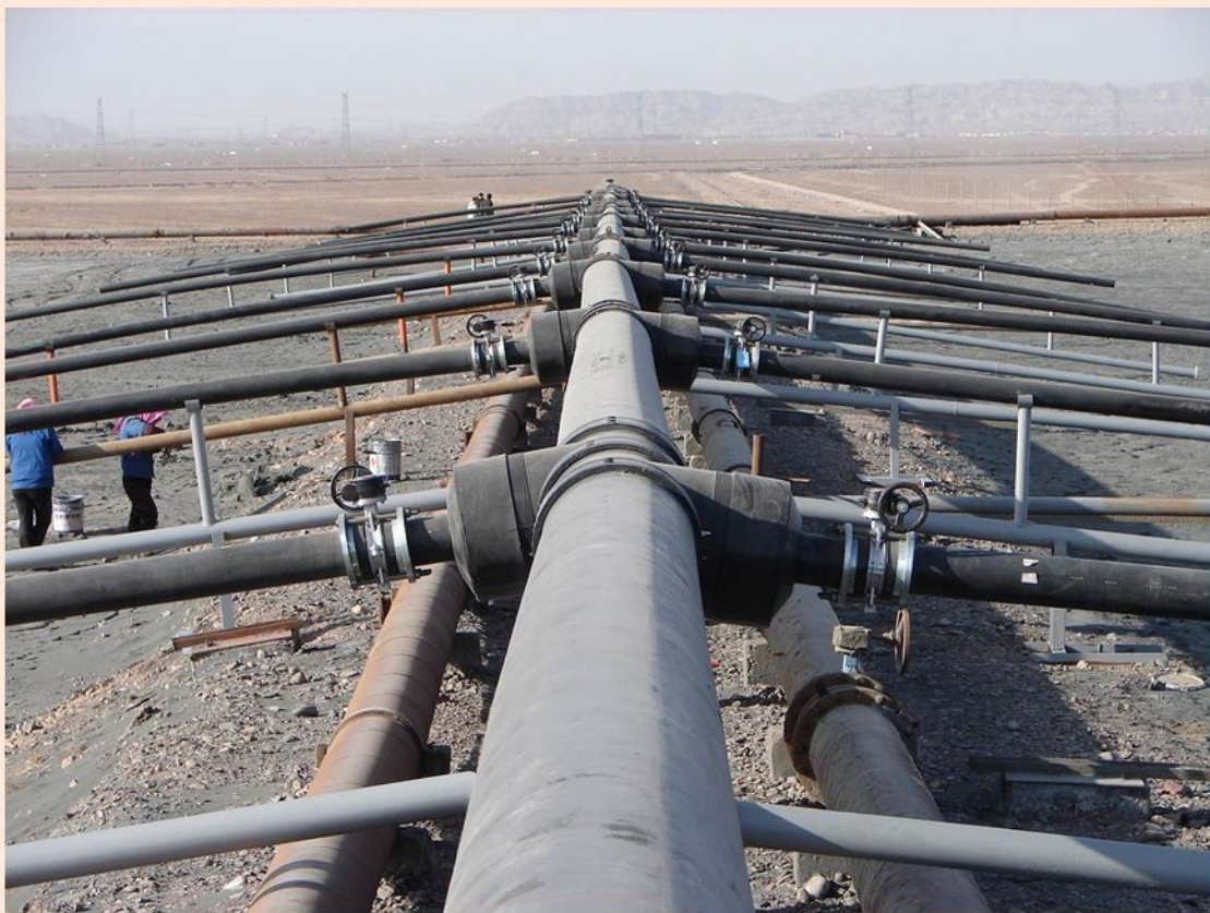
甘肃金川集团尾矿输送管线
