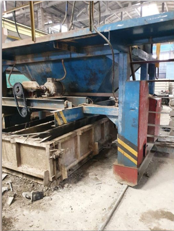
Желоб с бетоном
