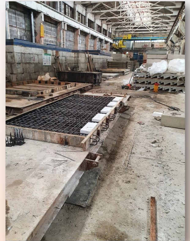
Анкеровка плиты покрытия
