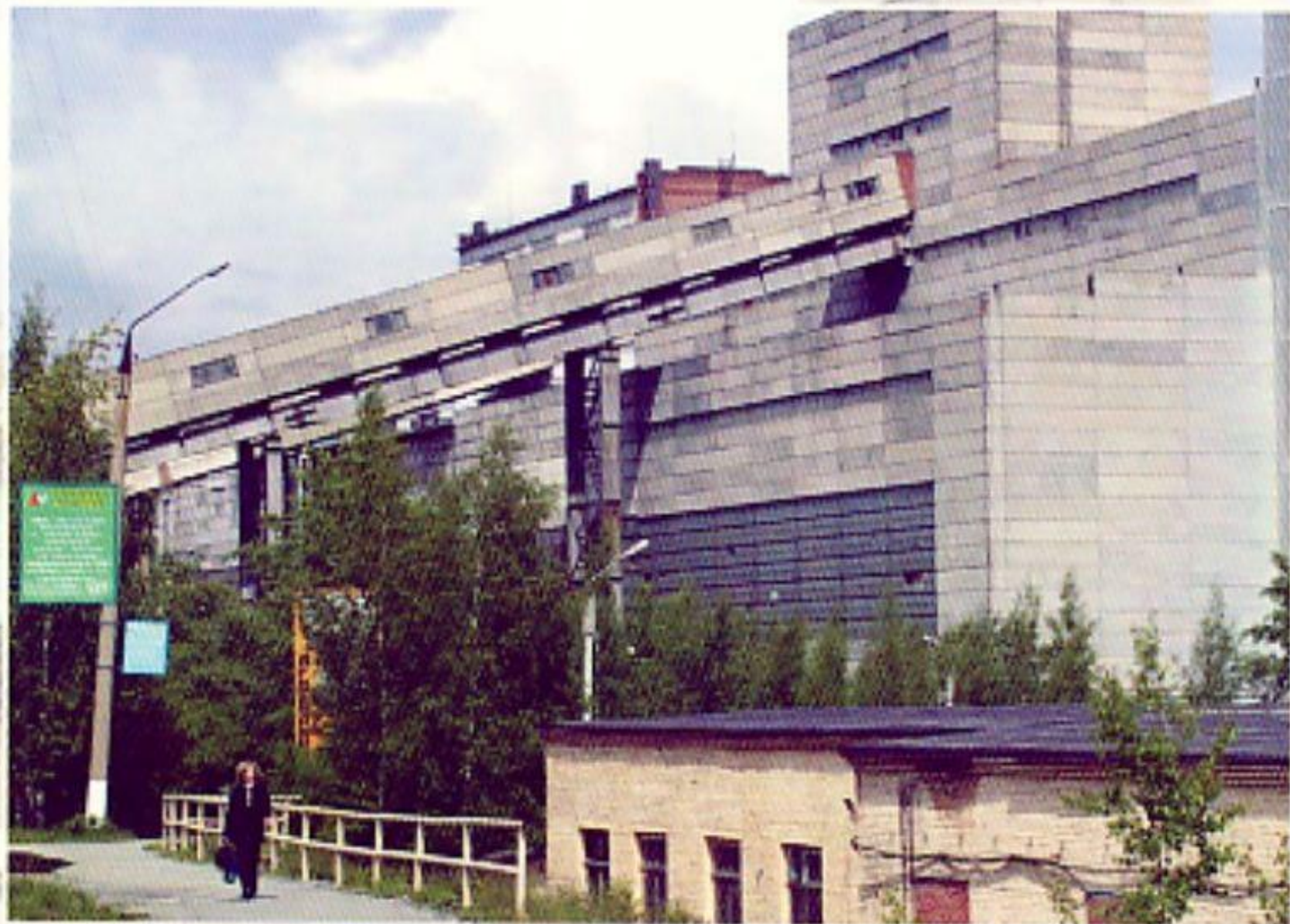
Корпус цеха дробления обогатительной фабрики
