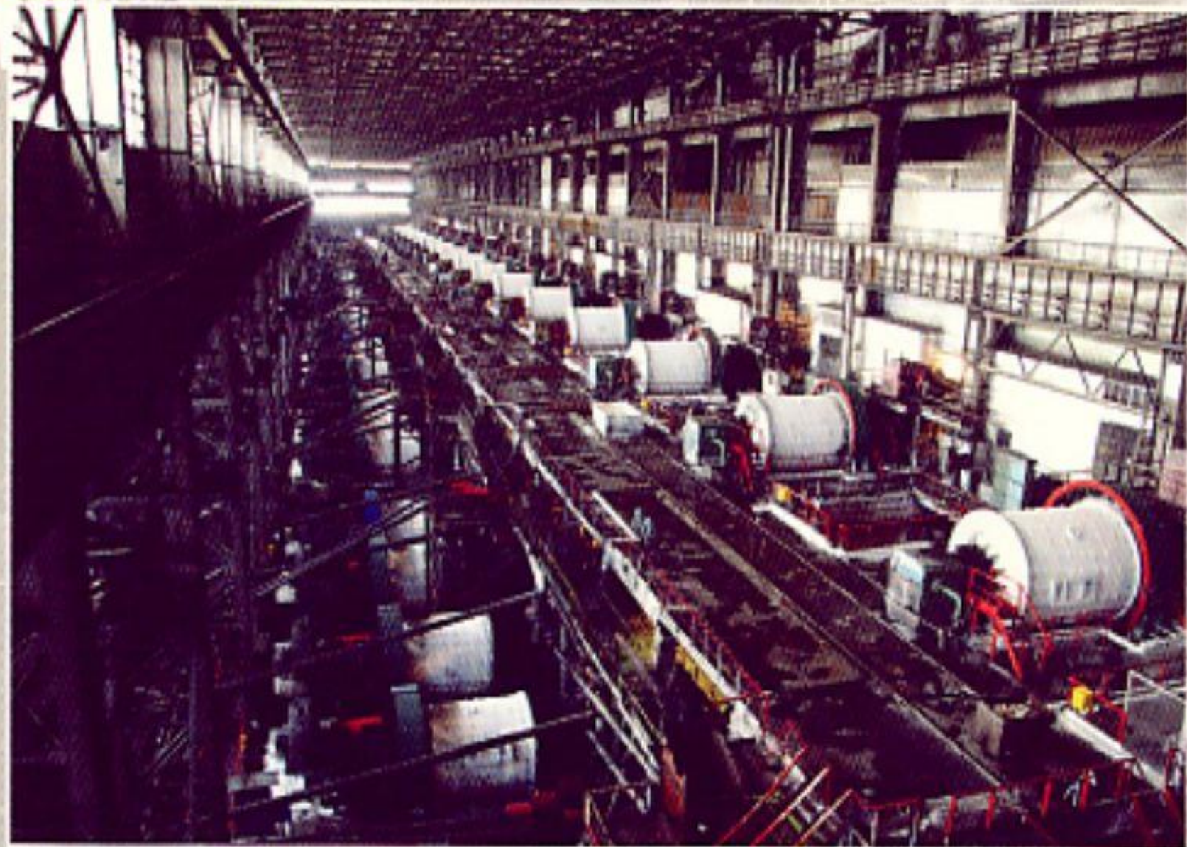
Мельничный пролет цеха обогащения обогатительной фабрики
