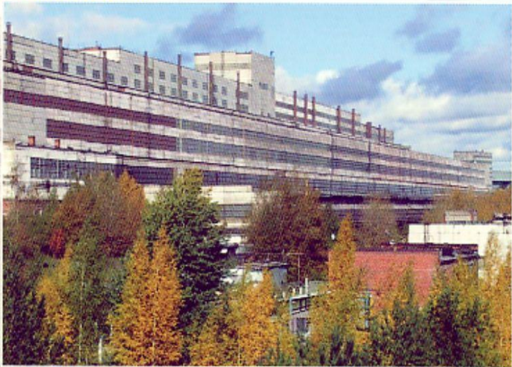
Корпус цеха обогащения обогатительной фабрики
