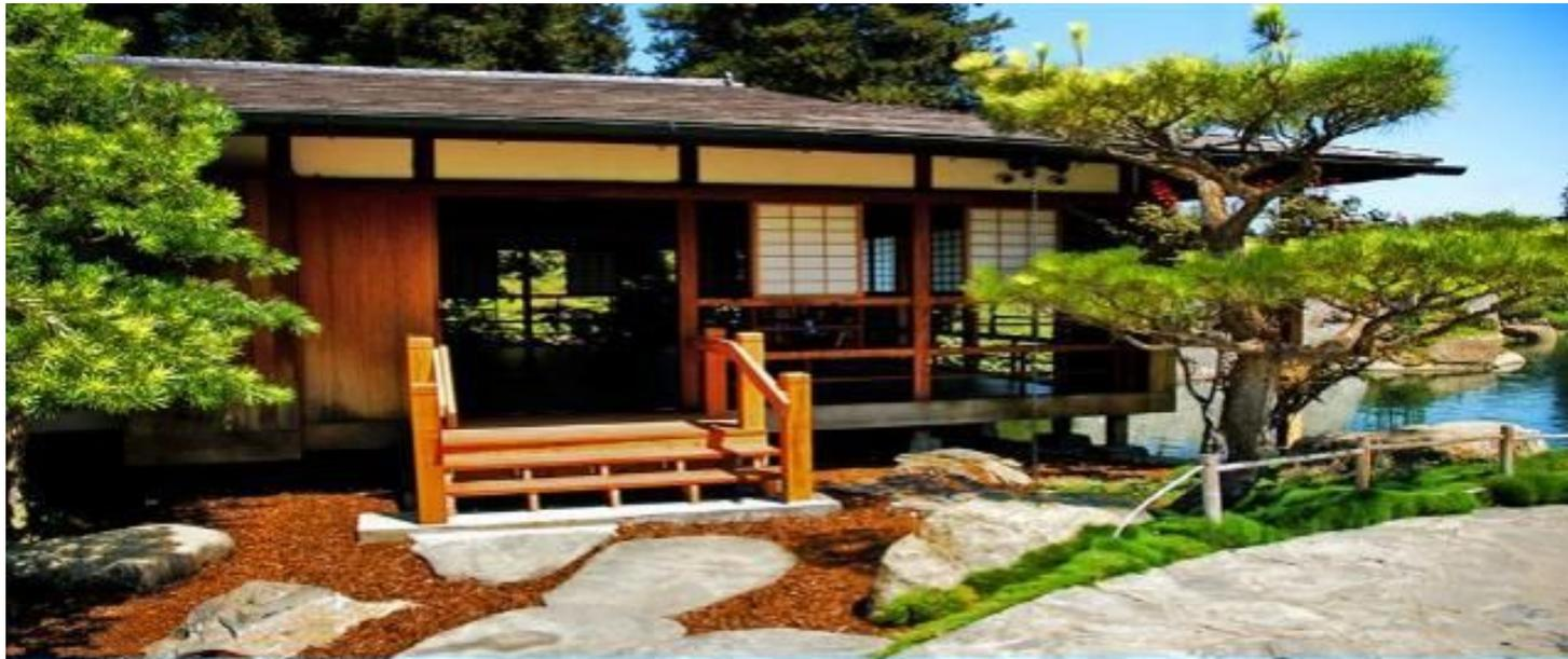
Конструкция традиционного японского дома сложилась к 17-18 в. Он представляет собой деревянный каркас с тремя подвижными стенами и одной неподвижной. Стены не несут функций опоры, поэтому они могут раздвигаться или даже сниматься, служить одновременно и окном. В тёплый сезон стены представляли собой решётчатую конструкцию, оклеенную полупрозрачной бумагой, пропускавшей свет, а в холодное и дождливое время их прикрывали или заменяли деревянными панелями
