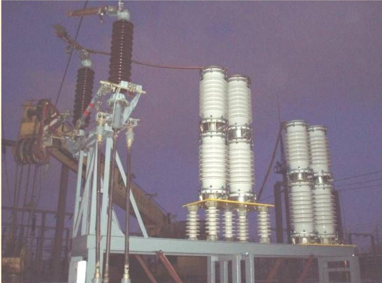
Токоограничивающее устройство (ТОУ-Н) для заземления нейтрали авто- и трансформаторов мощных станций или распределительных подстанций
