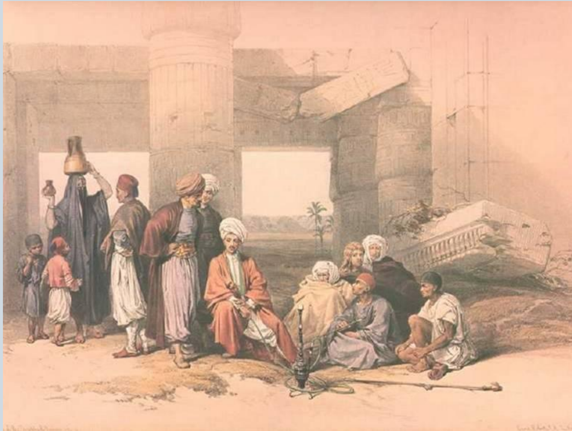
Судан. У разрушенного храма
