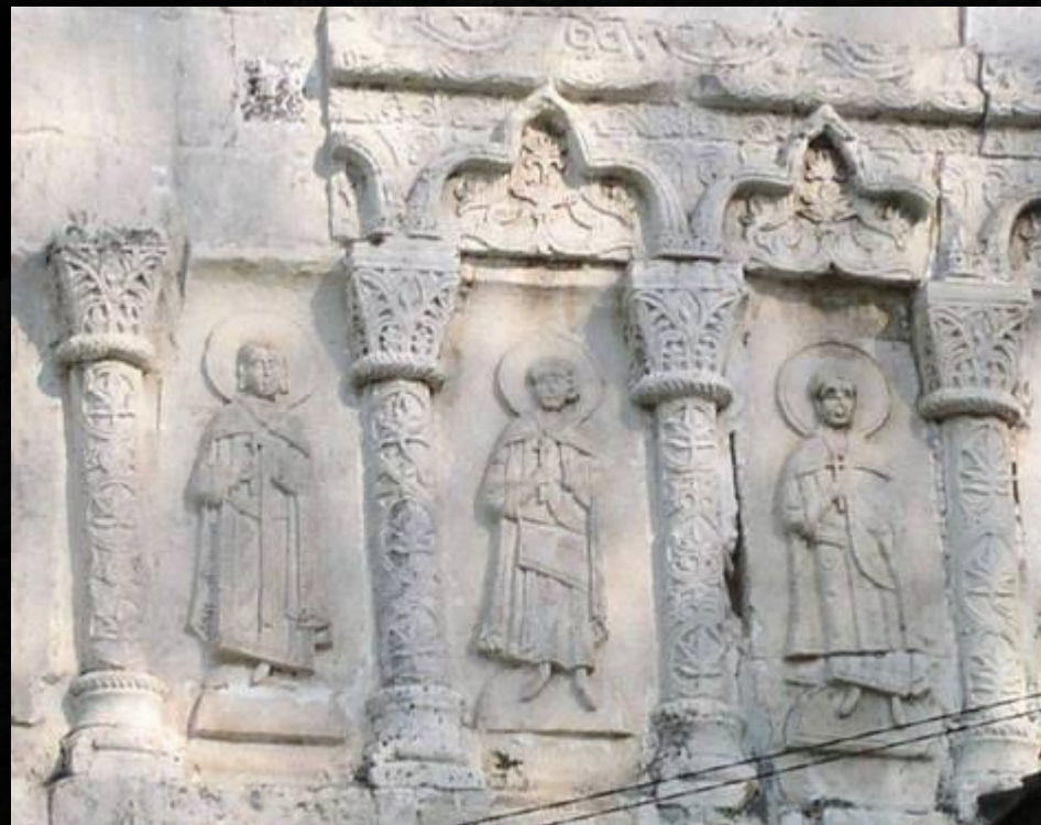
Георгиевский собор. Аркатурно-колончатый пояс
