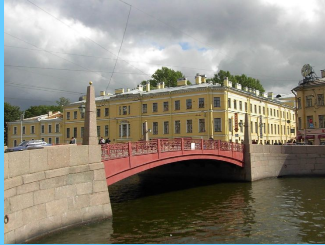
Красный мост 42 м
