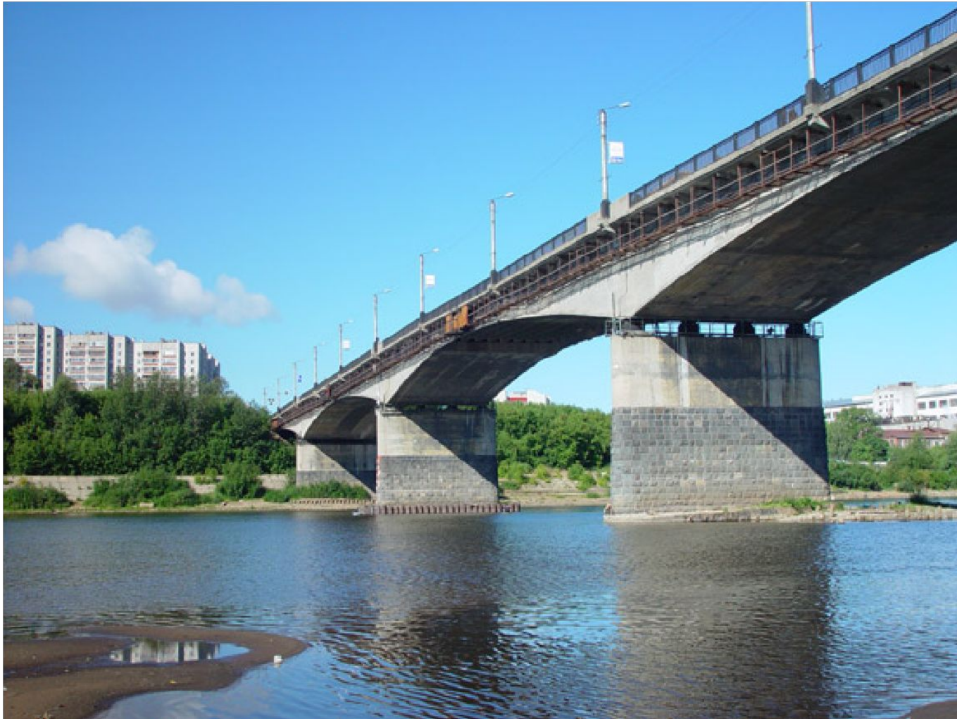
МОСТ ЧЕРЕЗ РЕКУ ВЯТКА
