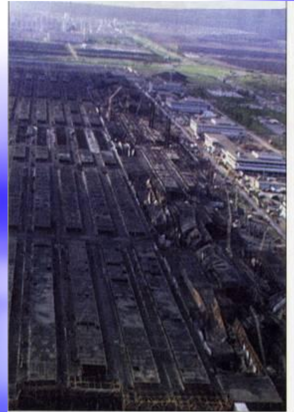
Последствия пожара на заводе двигателей АО «КамАЗ»
