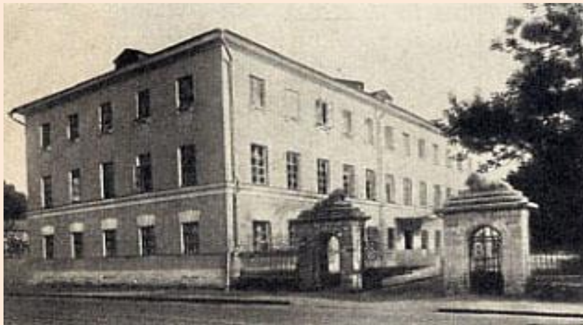
Фасад главного здания бывшей Мариинской больницы для бедных
