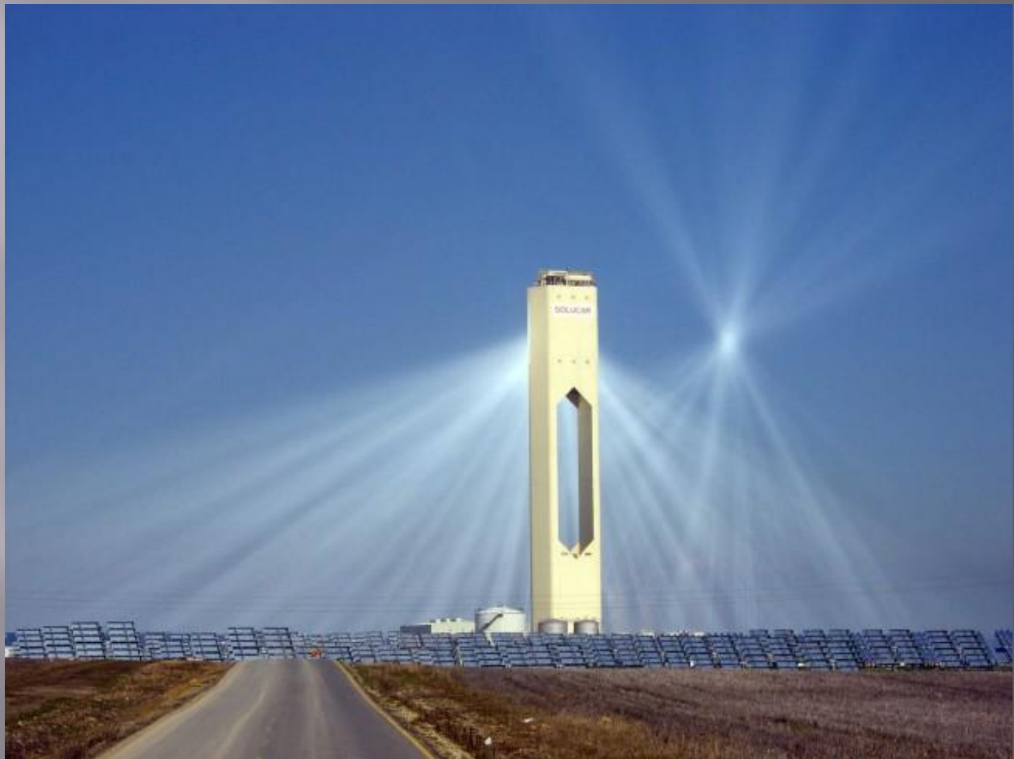
Солнечная термальняная электростанция в испанском городе Севилья
