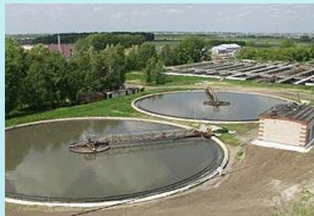
Вертикальный и радиальный отстойники
