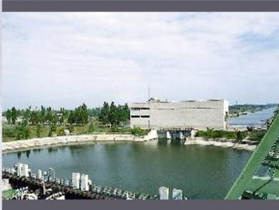
Водозаборное сооружение на канале Днепр-Донбасс.
