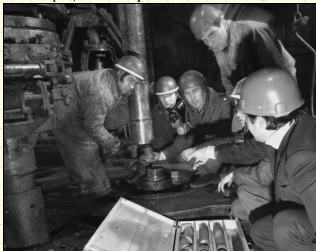
**Использовалась техника: установка «Уралмаш 4Э» грузоподъемностью 200 тонн и легкосплавные трубы**
