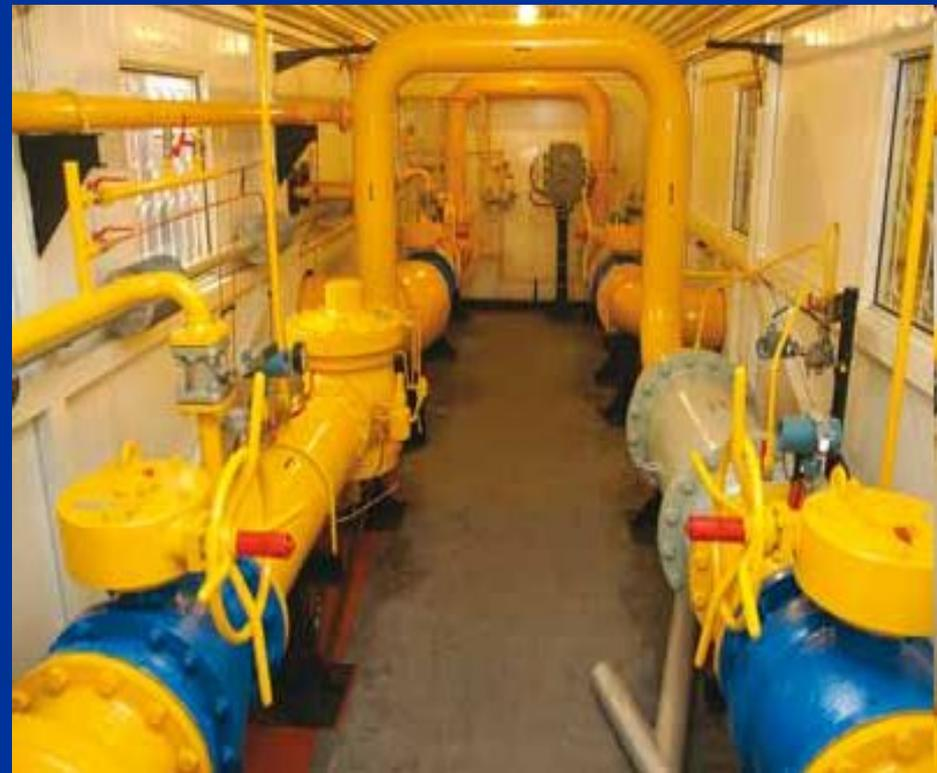
газорегуляторные пункты шкафные с узлом расчёта газа 'ГСГО-50-СГ', серии ГСГО, ГСГО-100, ГСГО-М, ГСГО-М/25, ГРПШН, ГРПШ-32.
