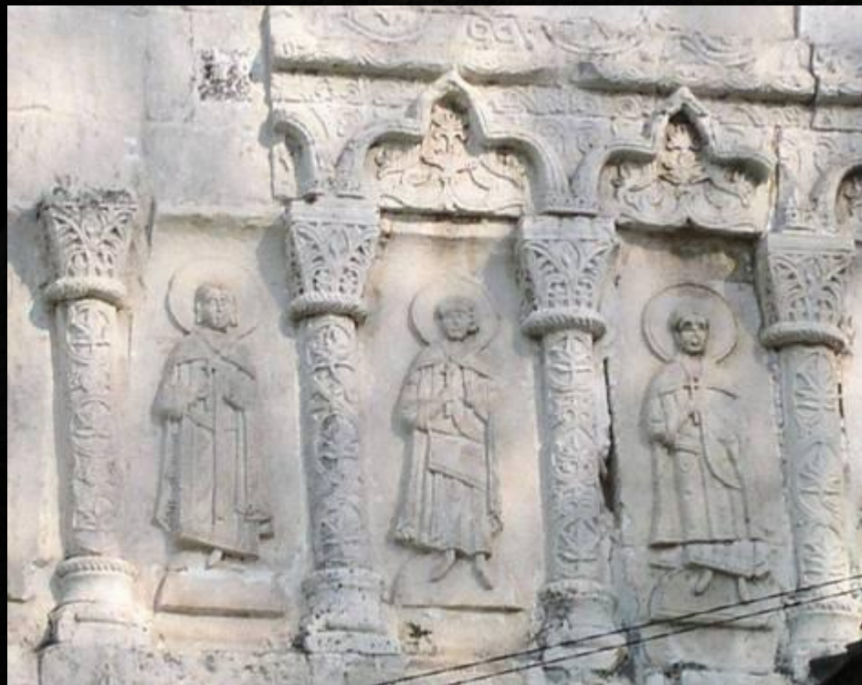
Георгиевский собор. Аркатурно-колончатый пояс
