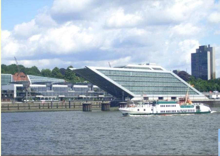
здание Dockland на берегу Эльбы
