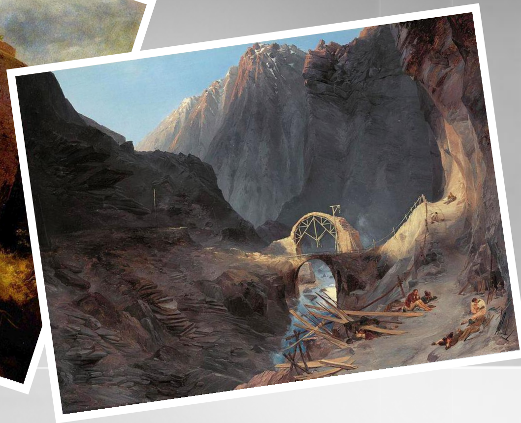
Постройка Чёртова моста, 1830-32
