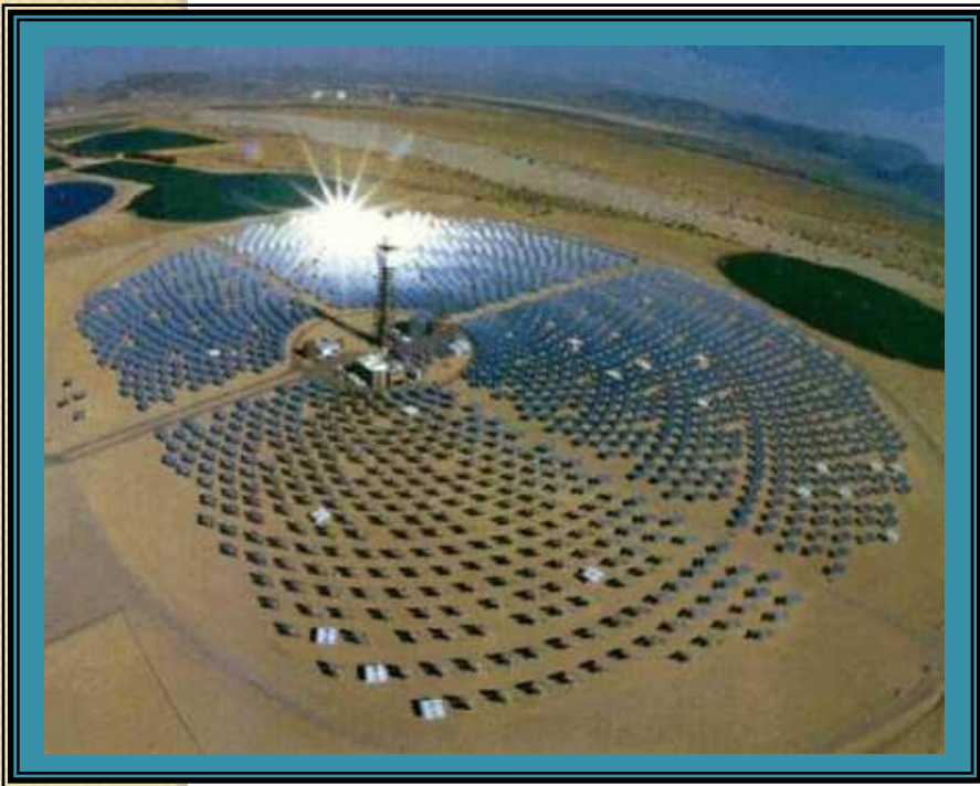
Солнечная электростанция (СЭС)
