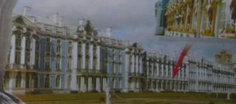
Пожарная опасность Екатерининского Дворца
