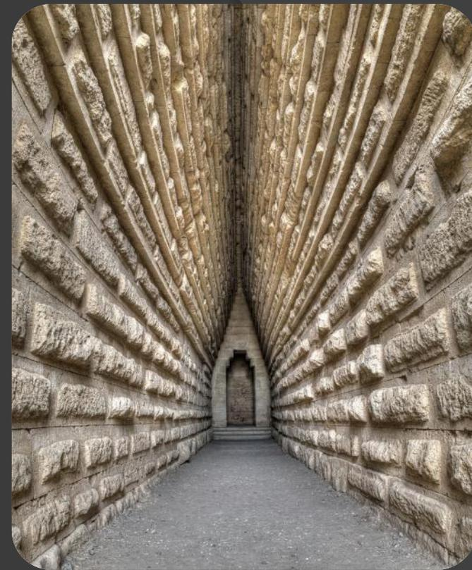
Внутри холма высотой 17 м. находится 36-метровый коридор из каменных блоков и погребальная камера, которая напоминает пирамиду. Цоколь погребальной камеры высечен из монолитной скалы, далее идут тщательно пригнанные друг к другу квадраты с гладко обработанной поверхностью, купол состоит из 12 постепенно уменьшающихся в диаметре концентрических колец, перекрытых плитой. Коридор, ведущий в погребальную камеру, по форме прохода напоминает кипарис, у древних греков считавшийся деревом мёртвых.
