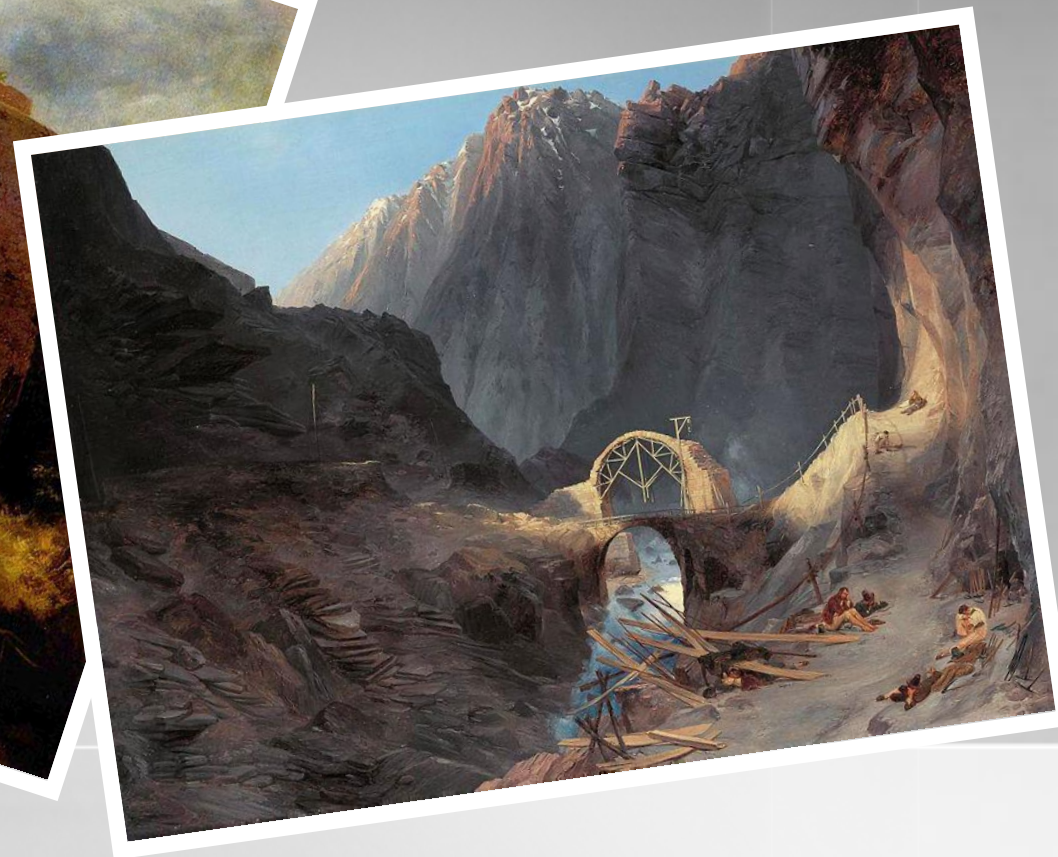
Постройка Чёртова моста, 1830-32
