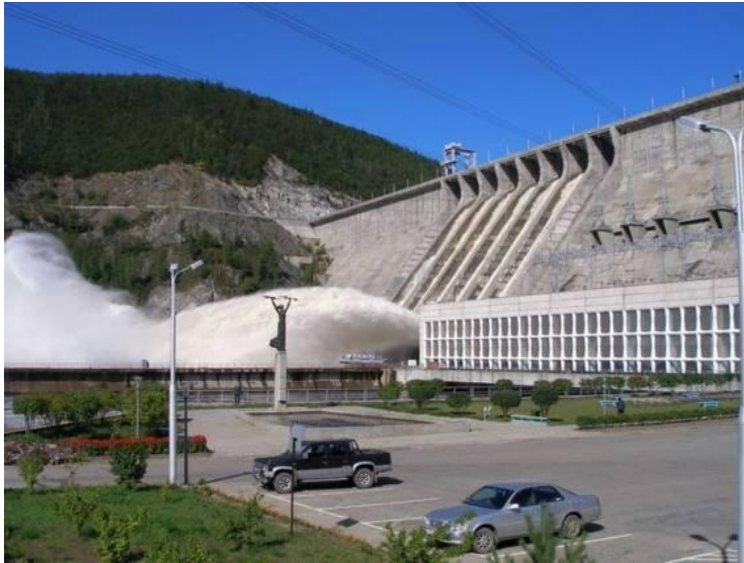
Плотина Зейской ГЭС (Амурская область) высотой 115,5 м
