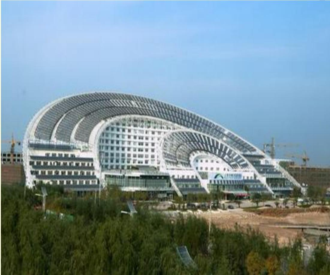
В китайском городе Дэчжоу построено самое большое в мире офисное здание с использованием энергосберегающих технологий. Площадь объекта составляет 75 тыс.м<sup>2</sup>. Энергообеспечение бизнес-центра полностью автономно и обеспечивается солнечной энергией. Фасад и крыша комплекса облицованы солнечными панелями. Экономия энергии за счет энергосберегающих решений на 30% превышает установленные стандарты.
