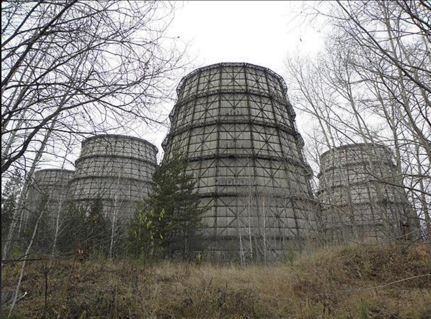
**Градирни** (Сибирской АЭС) - устройства для охлаждения большого количества воды направленным потоком атмосферного воздуха. Иногда градирни называют также **охлаждательными башнями**.
