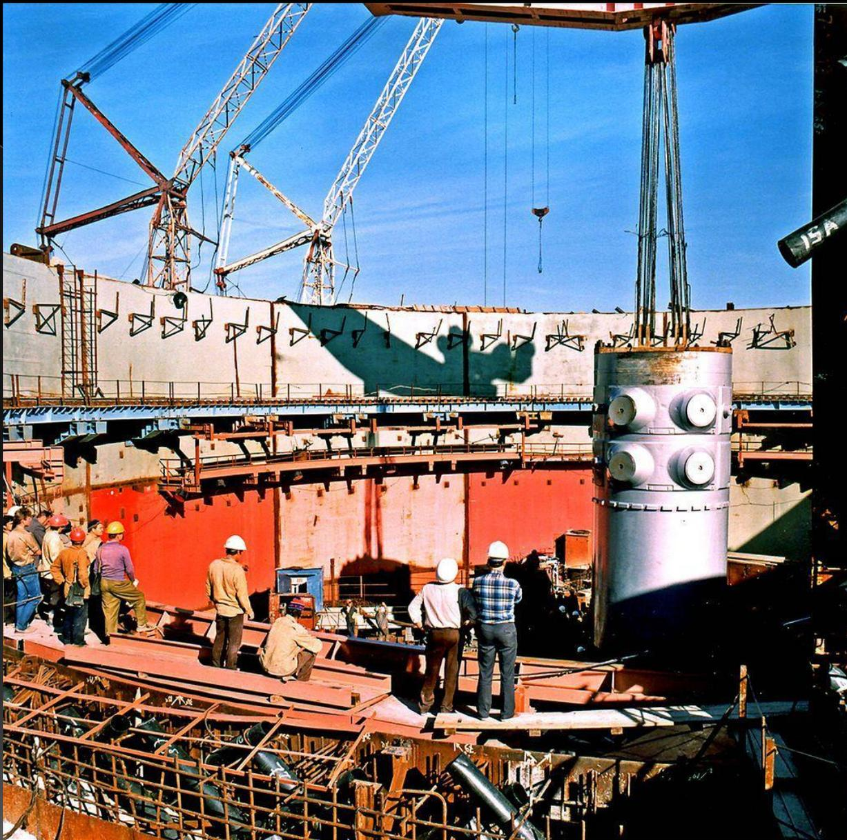
Монтаж корпуса реактора
