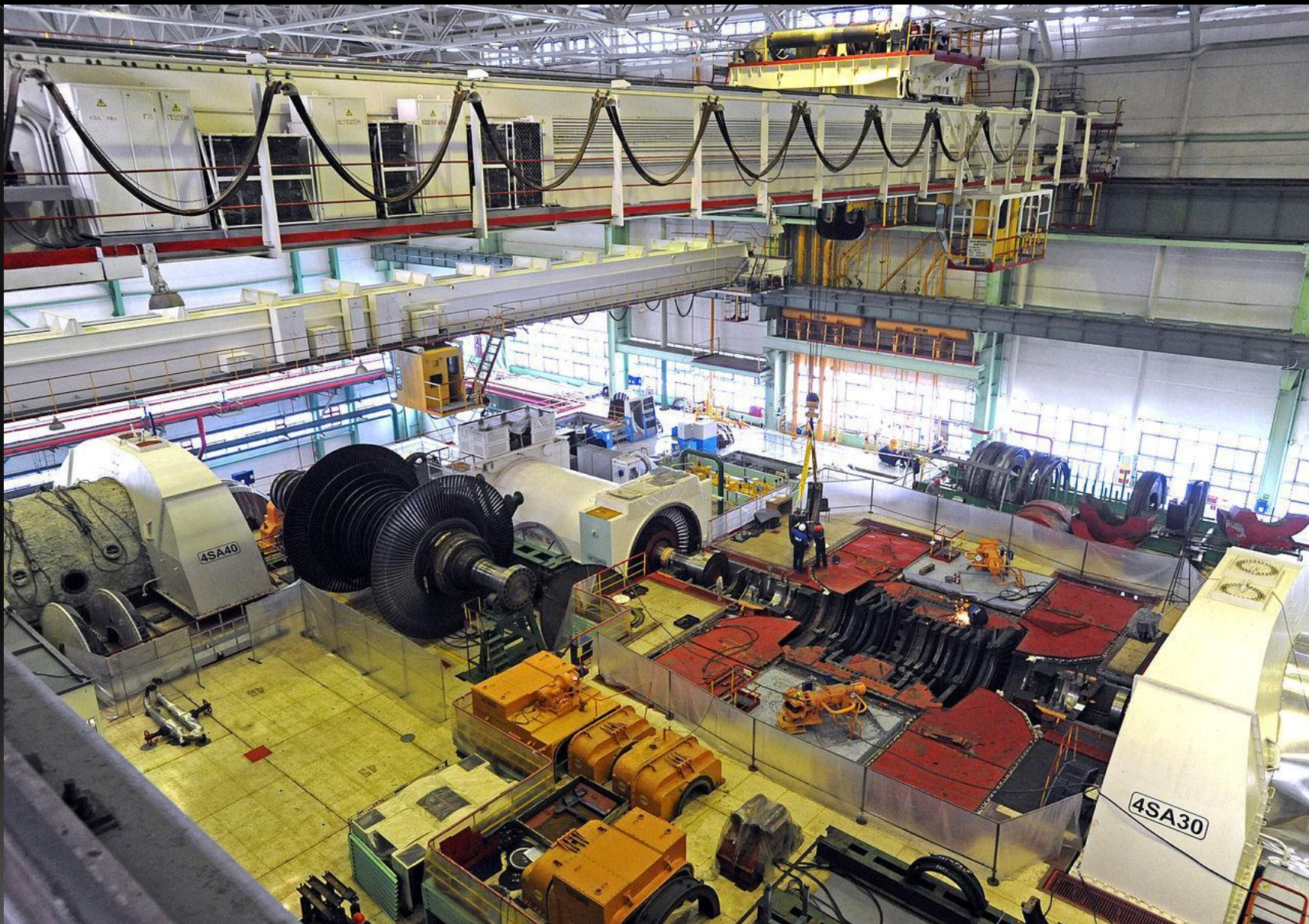
Плановый ремонт оборудования
