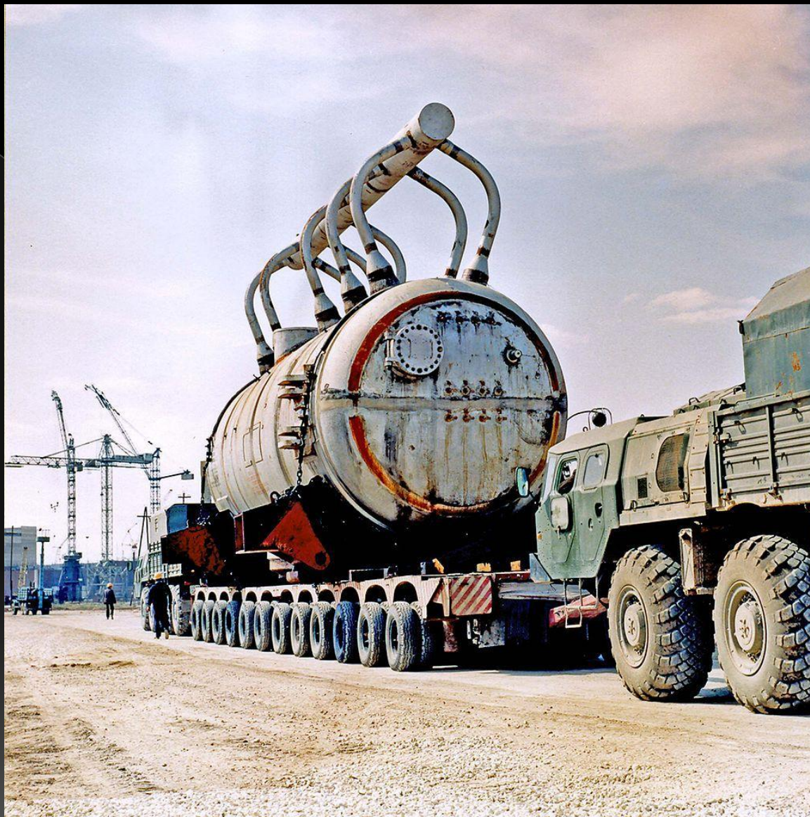
Прибытие парогенераторов на строительство
