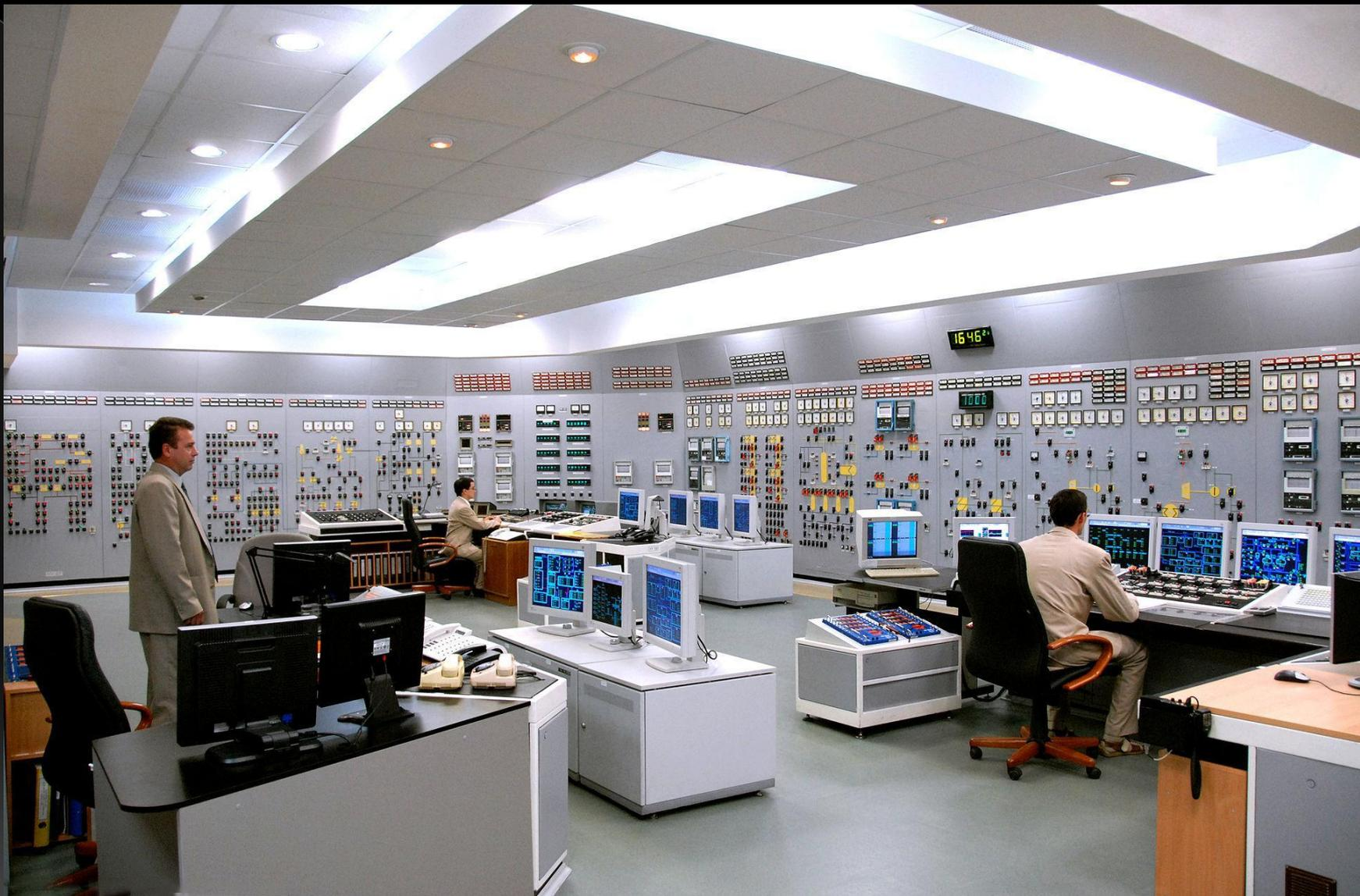
Блочный щит управления. За работой оперативный персонал: слева ведущий инженер по управлению реактором, справа — турбиной, позади них начальник смены блока.
