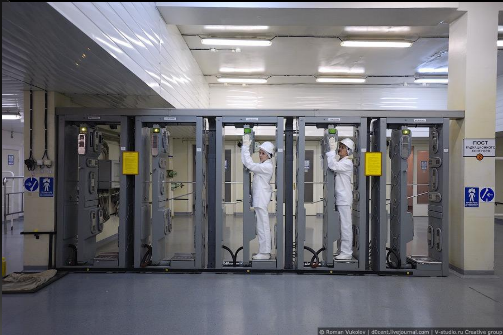
Дозиметрический контроль на выходе из зоны контролируемого доступа атомной электростанции
