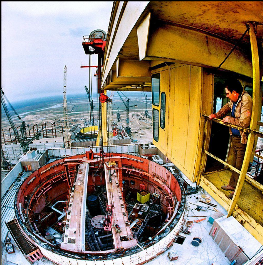
Поточное строительство на Балаковской АЭС: за блоком блок
