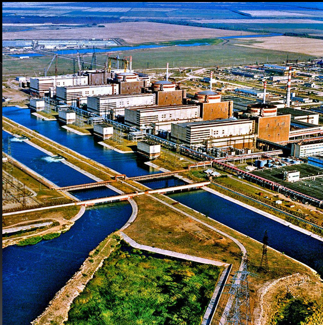
Вид сзади, подводящие каналы водоёма-охладителя с блочными насосными станциями на берегу
