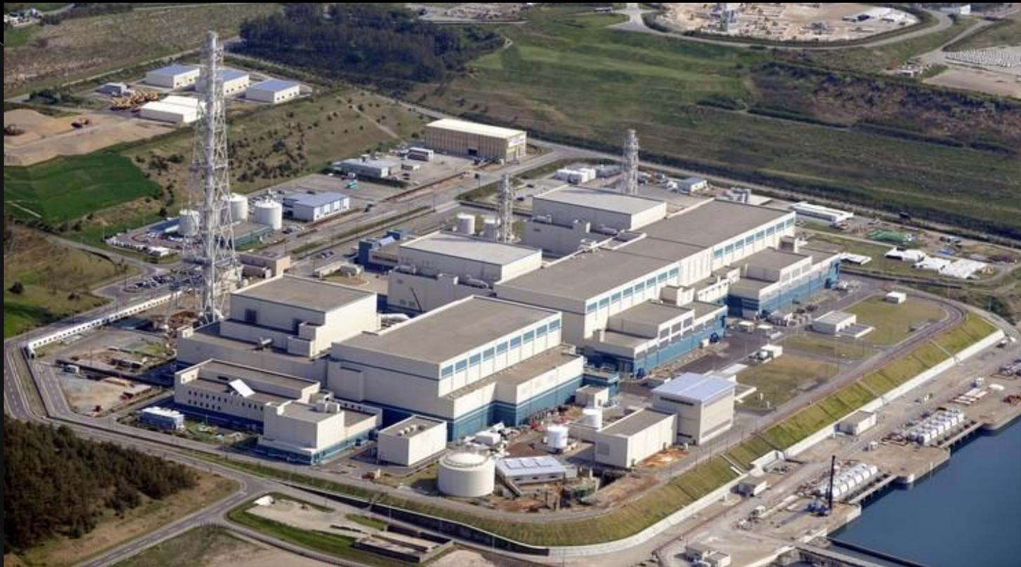
Крупнейшая АЭС в мире (по установленной мощности) — АЭС **Касивадзаки-Карива** (на 2008 год) находится в Японском городе Касивадзаки префектуры Ниигата. В эксплуатации находятся пять кипящих ядерных реакторов (BWR) и два улучшенных кипящих ядерных реактора (ABWR), суммарная мощность которых составляет **8,212 ГВт**. Однако станция не генерирует электричество с 2011 года.
