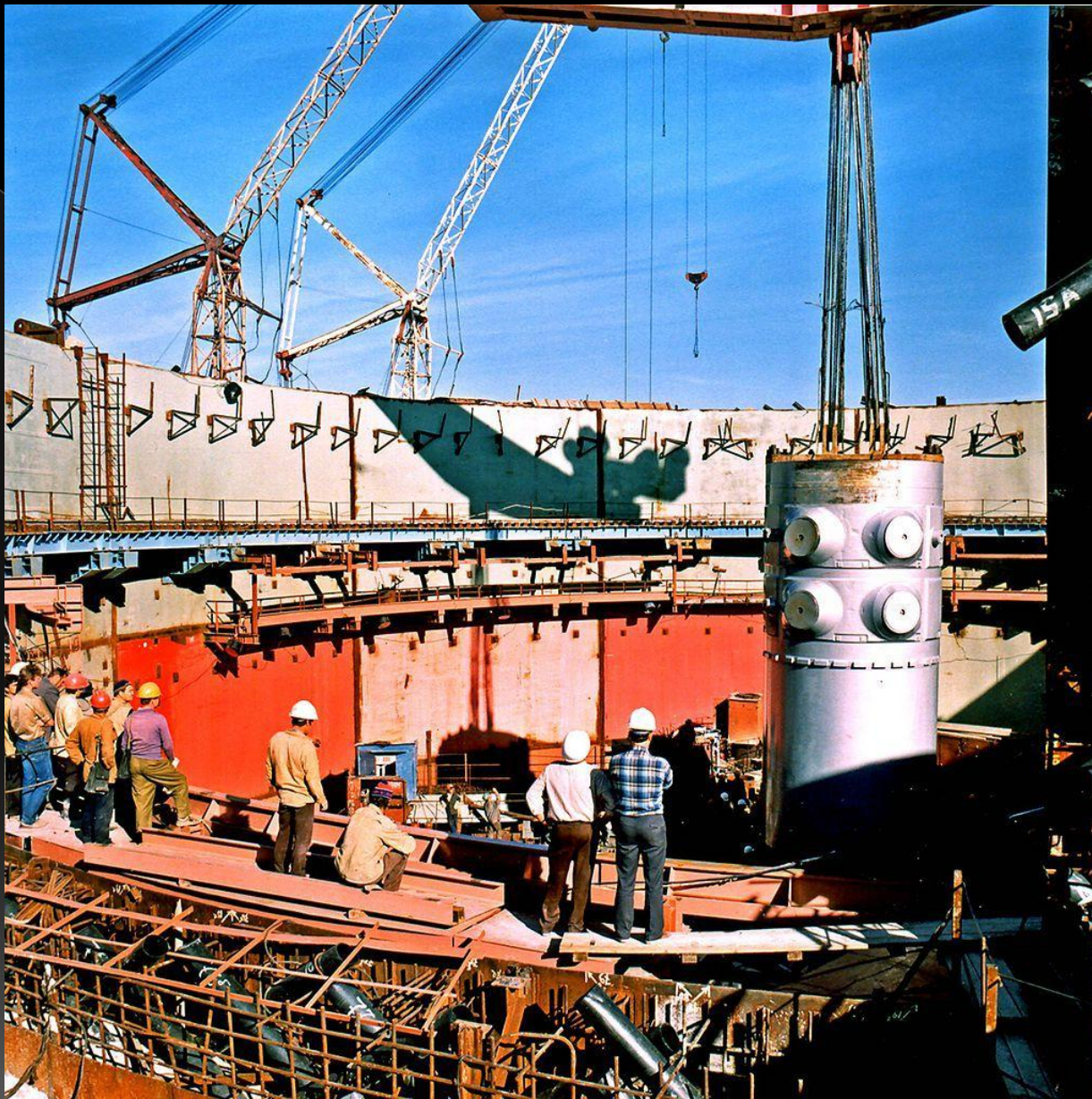
Монтаж корпуса реактора
