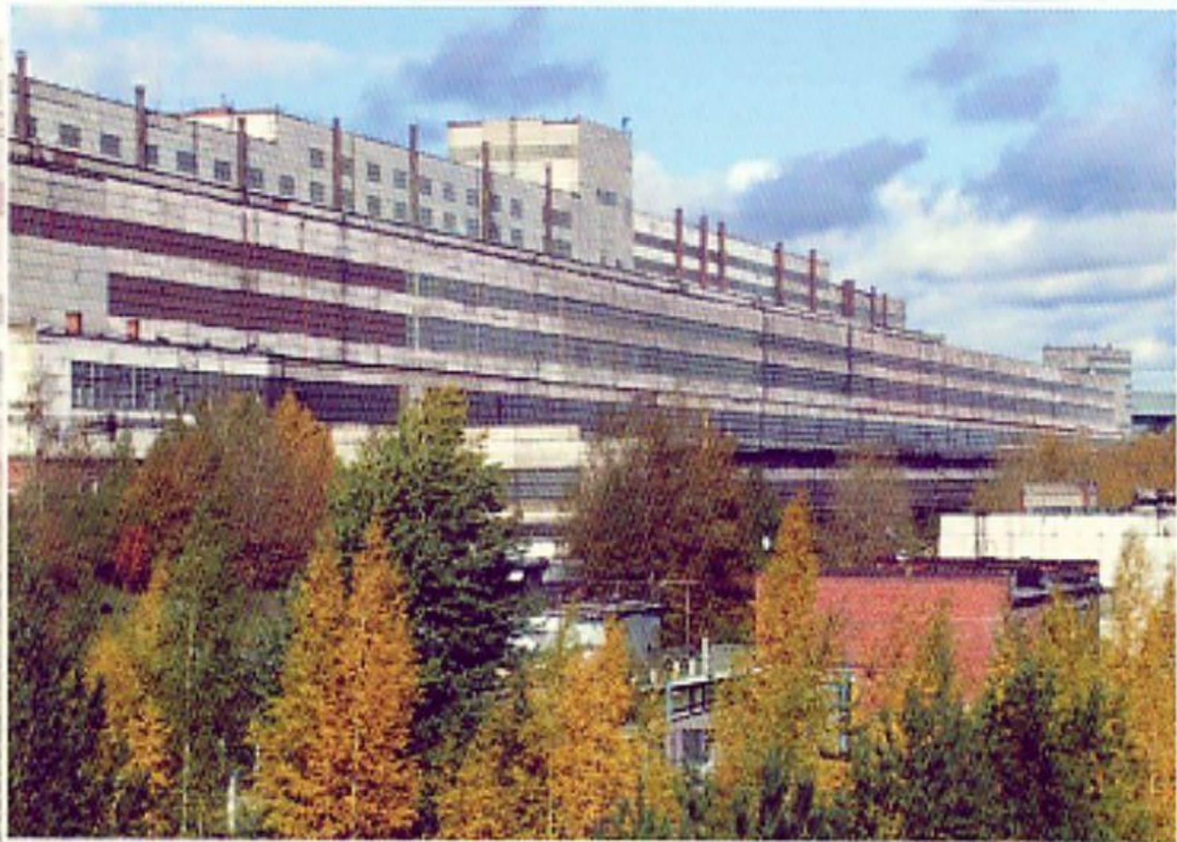
Корпус цеха обогащения обогатительной фабрики
