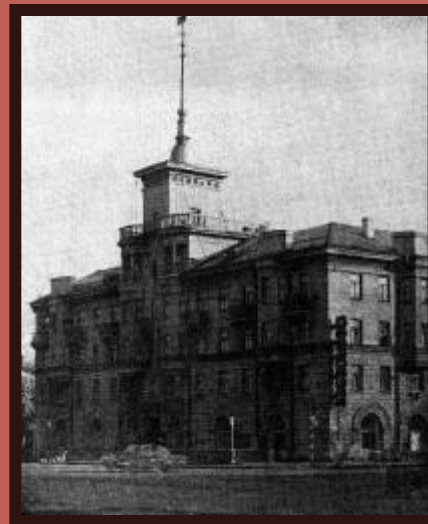
Жилой дом «под шпилем» на Октябрьской площади.1956
