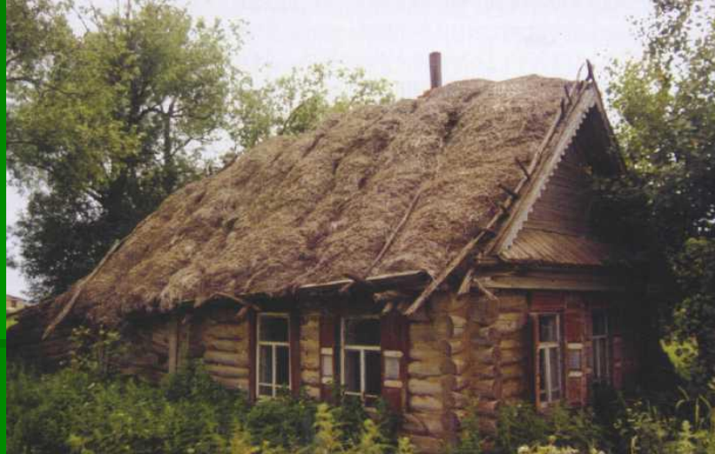
Единственный дом с соломенной крышей, сохранившийся в Новошешминске
