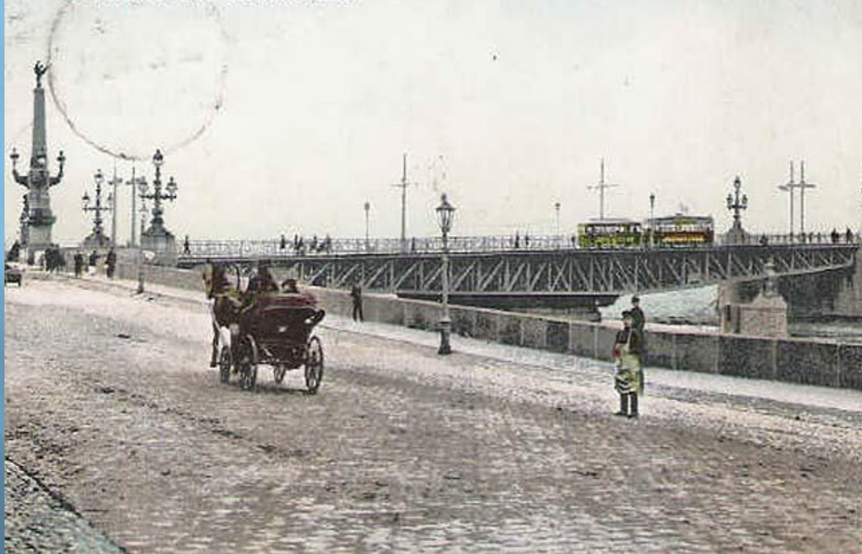
С.-ПЕТЕРБУРГЪ. Троицкій мостъ. ST.-PETERSBOURG. Le Pont Troïzky.
