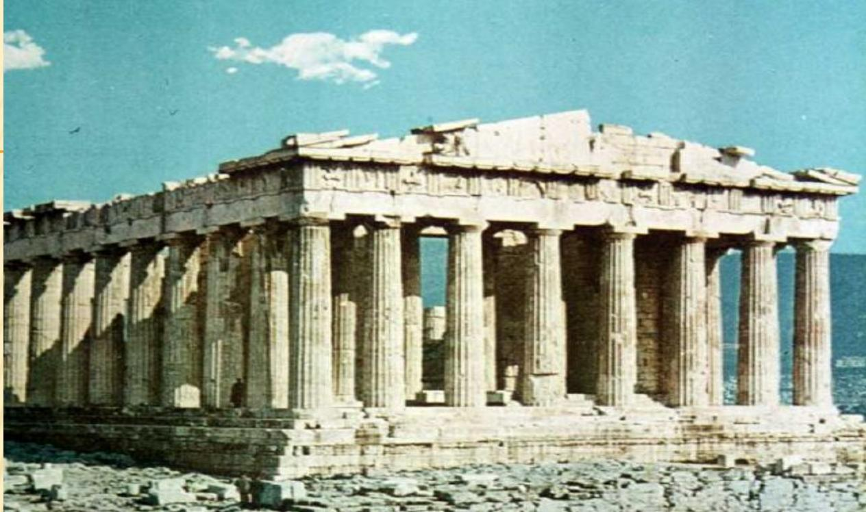
**ОРДЕРНАЯ СИСТЕМА** (ЛАТ. «ОРДЕР» – ПОРЯДОК) – ТАКОЙ ТИП АРХИТЕКТУРНОЙ КОНСТРУКЦИИ, КОГДА УЧИТЫВАЮТСЯ СОЧЕТАНИЕ И ВЗАИМОДЕЙСТВИЕ НЕСУЩИХ (ПОДДЕРЖИВАЮЩИХ) И НЕСОМЫХ (ПЕРЕКРЫВАЮЩИХ) ЭЛЕМЕНТОВ.
