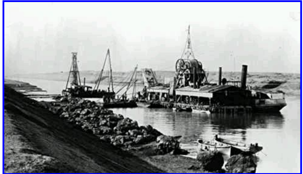
Строительство Суэцкого канала
