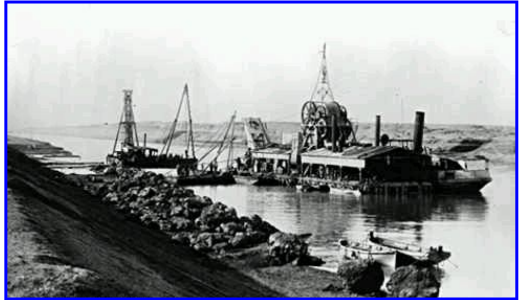
Строительство Суэцкого канала
